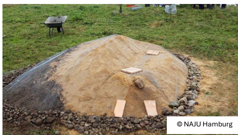
Insektenburg nach dem Bau
